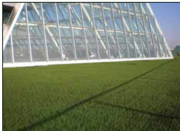
GEOFLOR® et gazon après 20 jours suivant l'incorporation des grilles.
